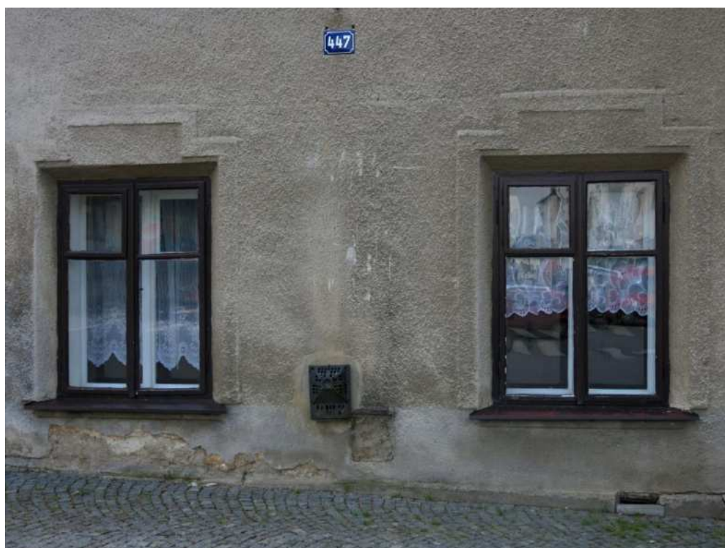
Dům č. p. 447, severní štítové průčelí, detail oken, foto AŘ 2015.
