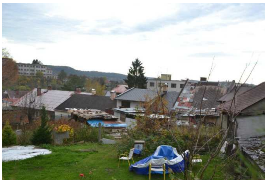
Celkový pohled na východní frontu domů v Markově ulici, dům č. p. 9 (druhý zleva) a pohled na střechy domů ze zahrad od východu, dům č. p. 9 (druhý zprava), foto IP 2013.
