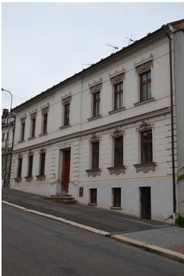
Dům č. p. 8, hlavní západní průčelí, foto IP 2013.
