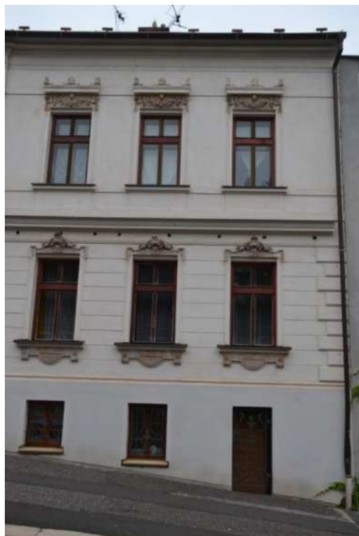
Dům č. p. 8, jižní část hlavního západního průčelí, foto IP 2013.
