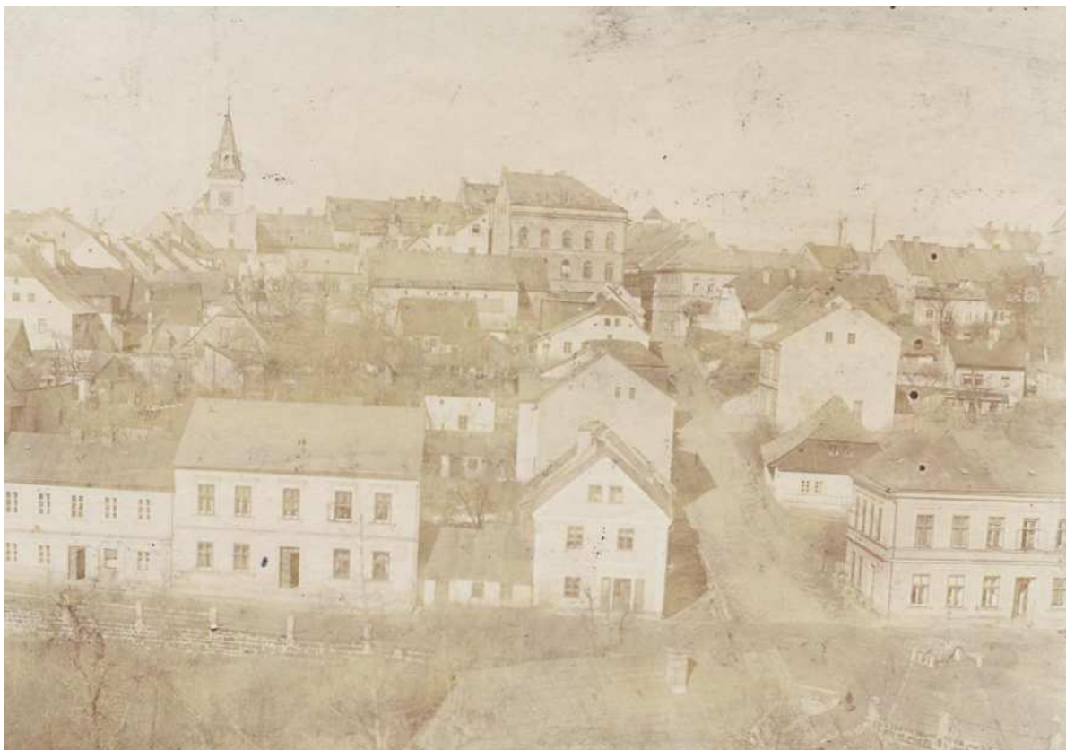
Pohled na Markovu ulici v 1. pol. 20. stol., na nároží Markovy ulice a ulice A. Dvořáka, v pravém dolním rohu je staré č. p. 311 s polovalbou i starší objekt střelnice v popředí, (foto sbírka MČR, inv. č. AFT 415).
