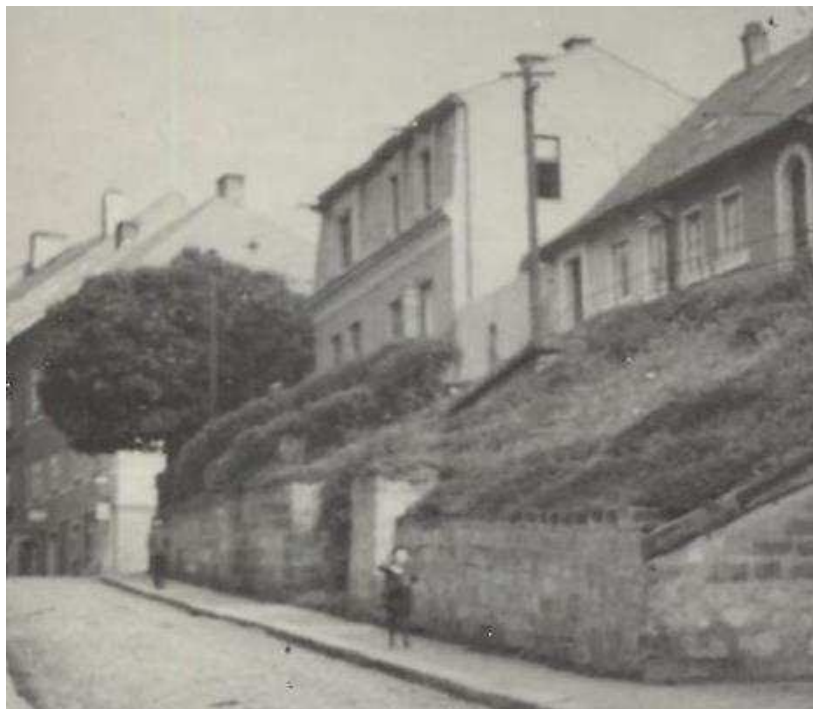
Dům č. p. 13 (třetí zprava) po přestavbě v roce 1925, zvýšena střecha a zřízeny podkrovní místnosti, (foto sbírka MČR, inv. č. AFT 419 d).
