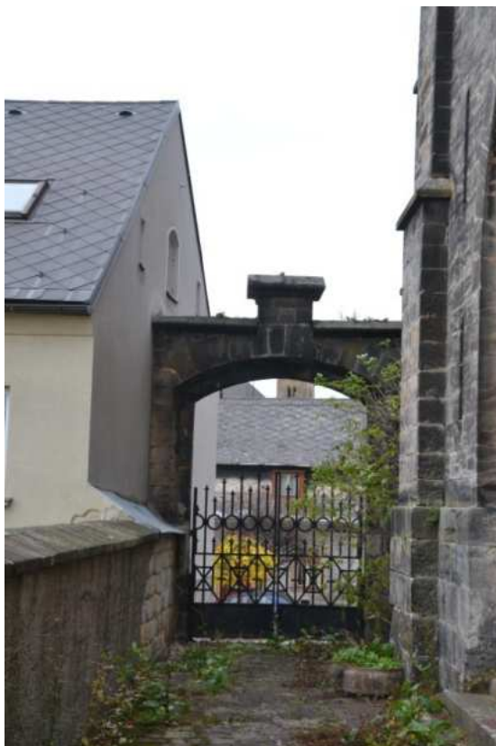
Dům č. p. 16, štítové východní průčelí sousedící s bránou na hřbitov, foto IP 2013.
