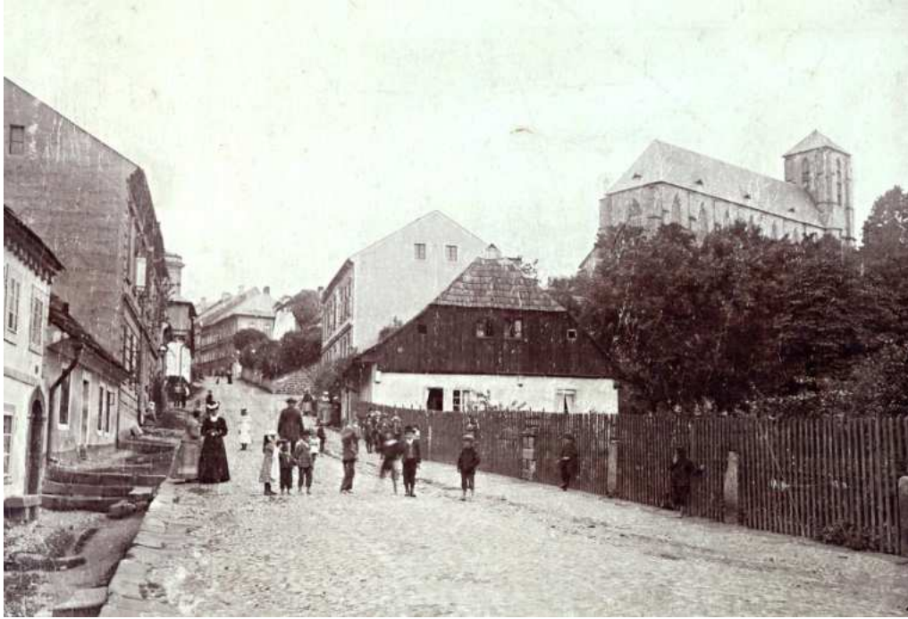
Pohled na Markovu ulici v 1. pol. 20. stol., za domem č. p. 311 vystupuje štítové průčelí č. p. 8 (druhý zprava), (foto sbírka MČR, inv. č. AFT 1070).
