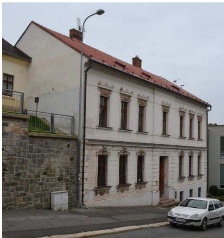
Celkový pohled na dům č. p. 8 od severozápadu, foto IP 2013.
