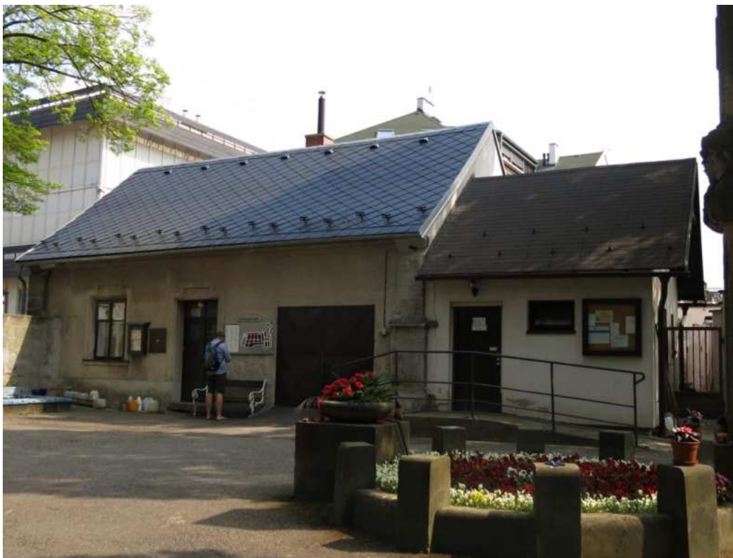
Dům č. p. 447, západní okapové průčelí, foto AŘ 2015.
