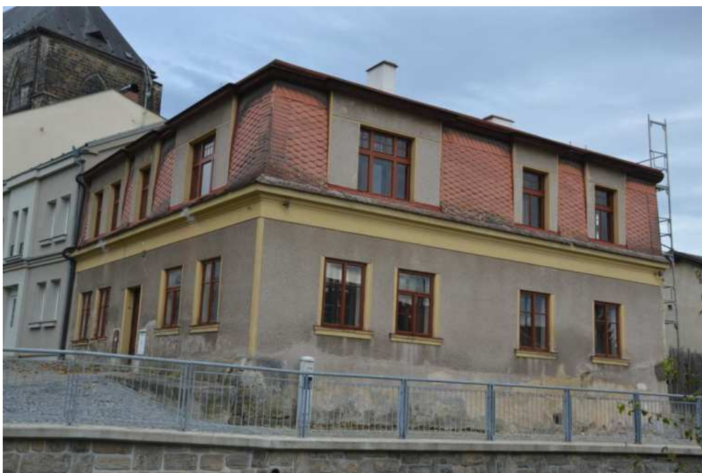
Celkový pohled na dům č. p. 13 na nároží Markovy ulice a Mariánského náměstí, foto IP 2013.
