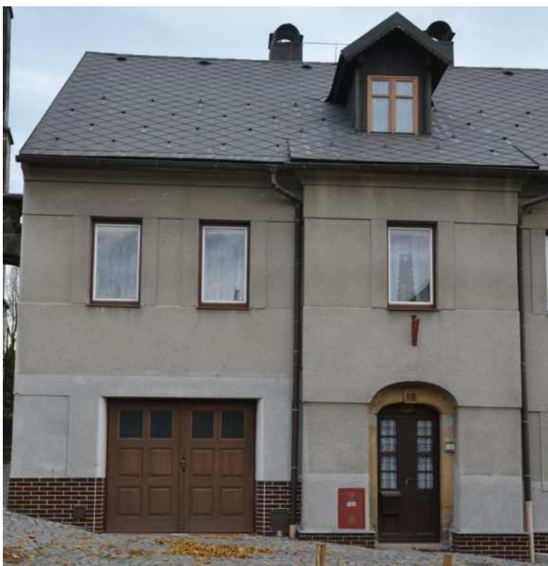
Dům č. p. 16, část hlavního severního průčelí, foto IP 2013.
