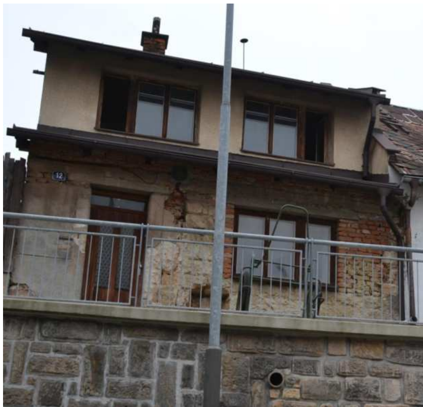
Dům č. p. 12, hlavní západní průčelí, foto IP 2013.
