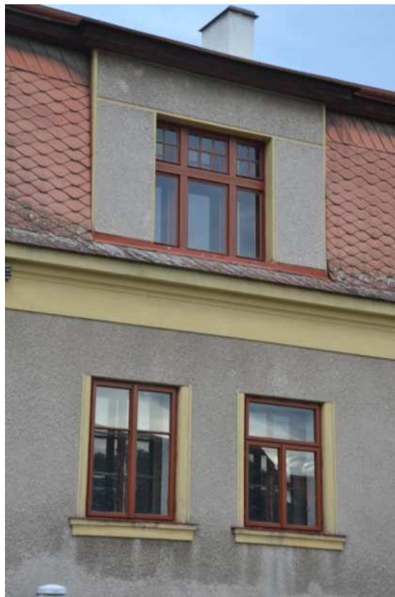
Dům č. p. 13, detail oken bočního západního průčelí, foto IP 2013.
