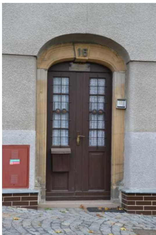
Dům č. p. 16, detail vstupního portálu v hlavním severním průčelí, foto IP 2013.
