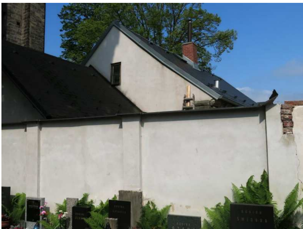
Dům č. p. 447, jižní štítové průčelí a střecha přístavby, foto AŘ 2015.
