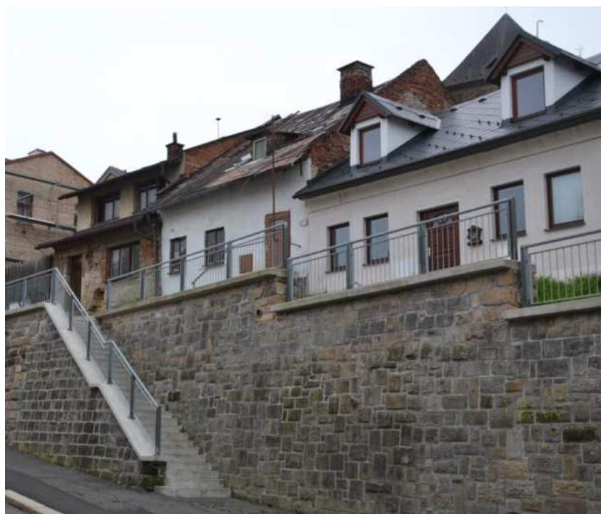
Celkový pohled na východní frontu Markovy ulice, dům č. p. 11 (druhý zprava), foto IP 2013.
