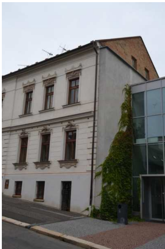
Dům č. p. 8, jihozápadní nároží a k jižnímu štítovému průčelí přistavěná novostavba č. p. 311, foto IP 2013.
