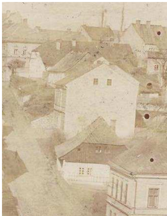
Pohled na Markovu ulici v 1. pol. 20. stol., za patrovým vysokým domem č. p. 8 vystupuje řada střech sedlových zčásti i č. p. 12, (foto sbírka MČR, inv. č. AFT 415).
