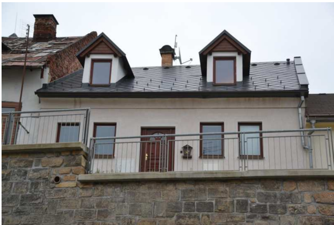
Dům č. p. 10, hlavní západní průčelí, foto IP 2013.
