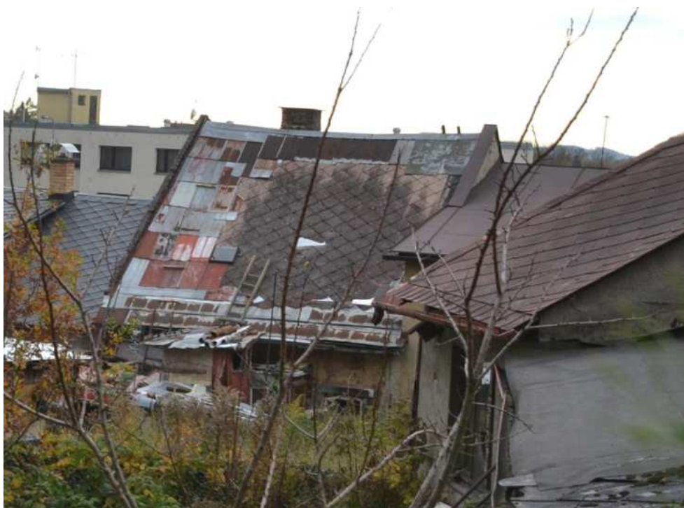
Dům č. p. 11, zadní východní průčelí, detail střechy, foto IP 2013.
