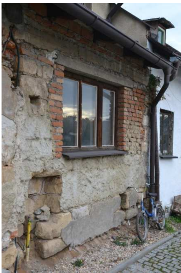
Dům č. p. 12, detail zdiva hlavního průčelí, foto IP 2013.
