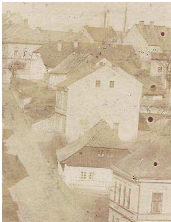
Pohled na Markovu ulici v 1. pol. 20. stol., za patrovým vysokým domem č. p. 8 vystupuje řada střech sedlových zčásti i č. p. 11, (foto sbírka MČR, inv. č. AFT 415).
