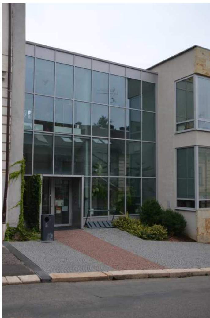
Dům č. p. 311, vstup v Markově ulici přistavěný ke štítu č. p. 8, foto IP 2013.
