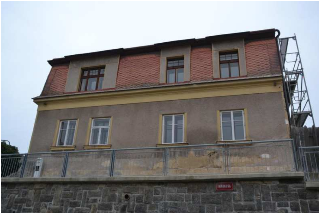
Dům č. p. 13, boční západní průčelí, foto IP 2013.
