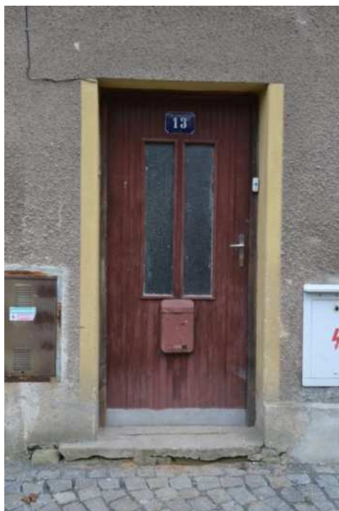
Dům č. p. 13, detail vstupních dveří v severním průčelí, foto IP 2013.
