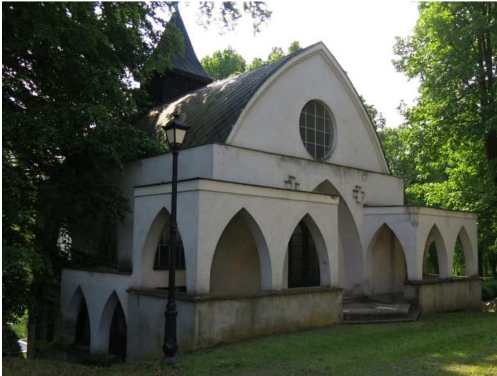
Smuteční síň, hlavní vstupní průčelí, foto AŘ 2015.
