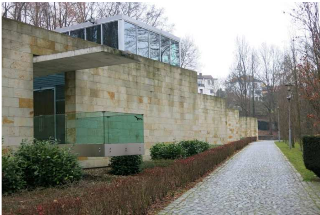
Objekt č. p. 310, celkový pohled od jihu, foto AŘ 2015.
