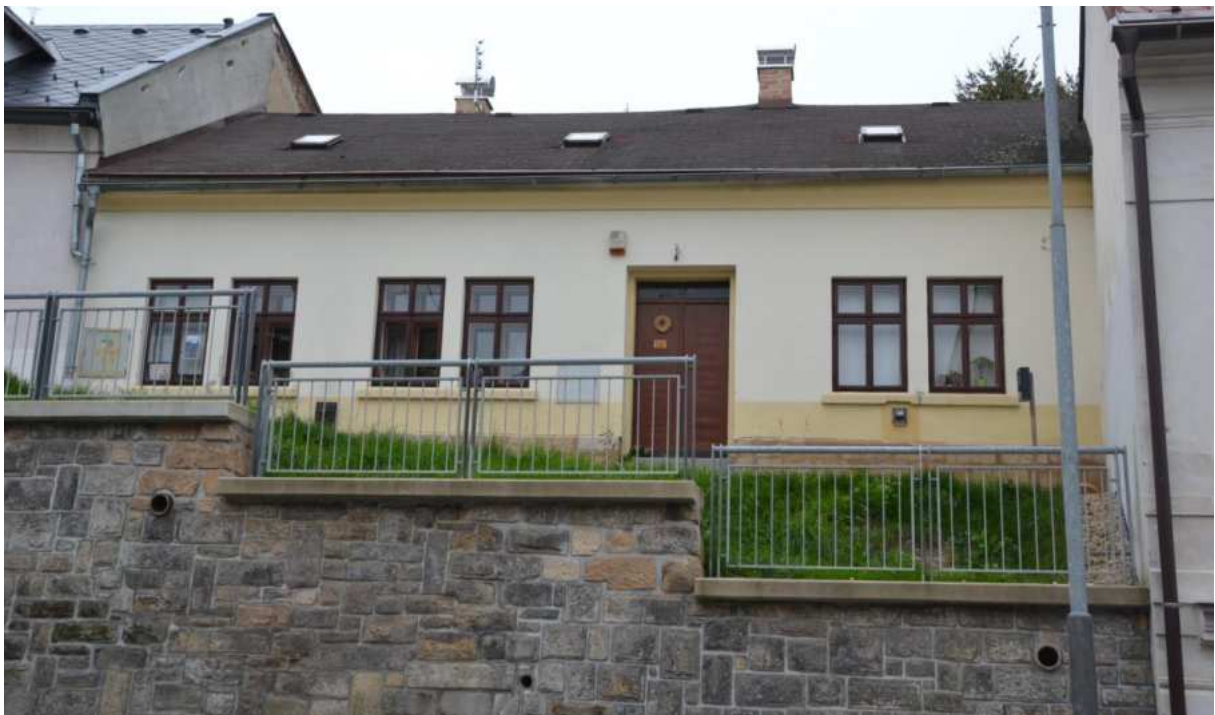
Dům č. p. 9, hlavní západní průčelí, foto IP 2013.
