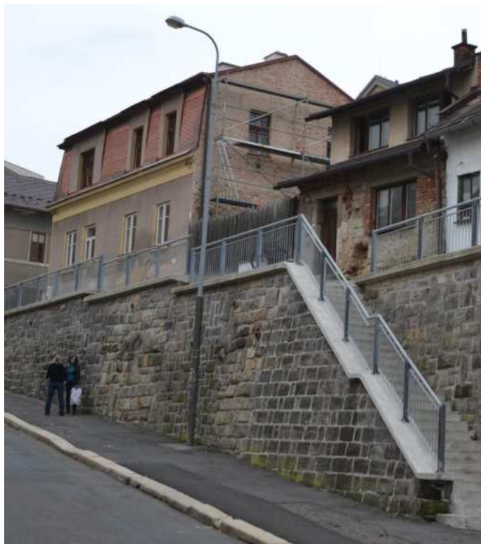
Dům č. p. 13, boční západní průčelí a zadní jižní průčelí, foto IP 2013.
