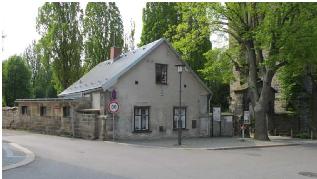
Dům č. p. 447, severní štítové průčelí, foto JZ 2015.
