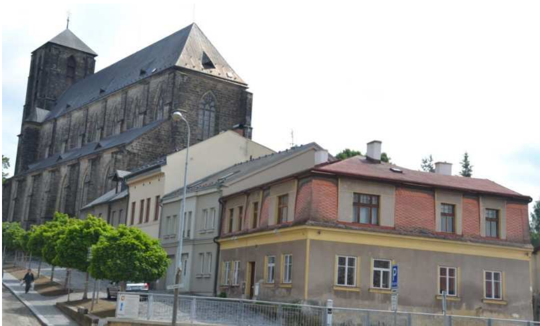
Celkový pohled na jižní frontu domů na Mariánském náměstí, dům č. p. 14 (druhý zprava), foto IP 2013.
