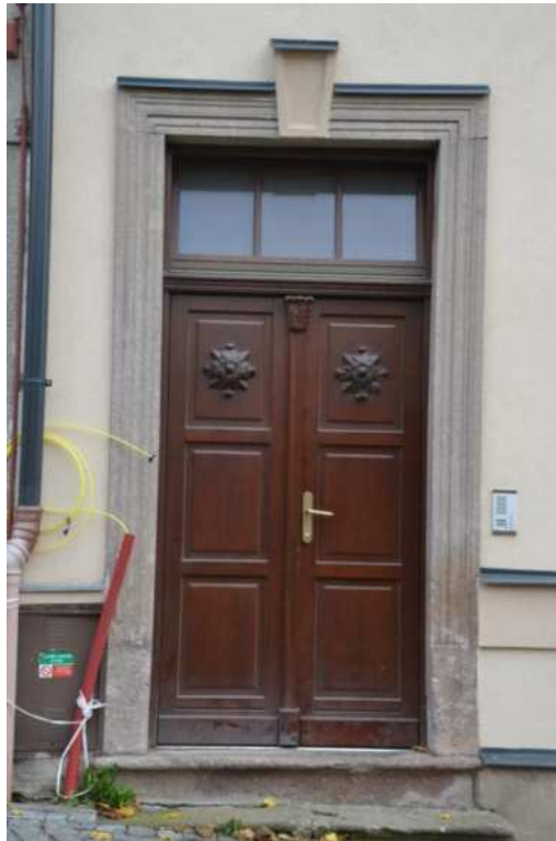
Dům č. p. 15, detail vstupní portálu u hlavního průčelí, foto IP 2013.
