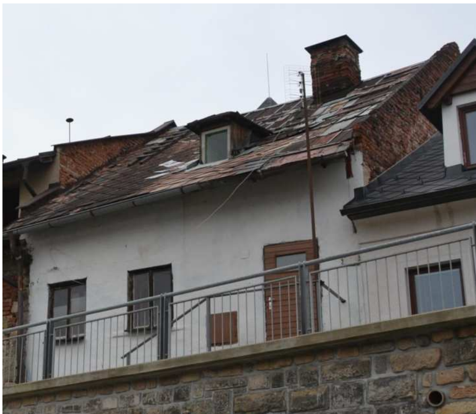
Dům č. p. 11, hlavní západní průčelí, foto IP 2013.
