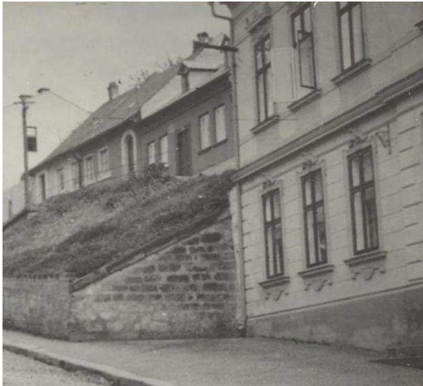
Část fasády hlavního průčelí č. p. 8 v 1 pol. 20. stol. (první zprava), (foto sbírka MČR, inv. č. AFT 419 d).
