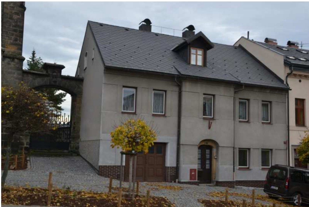
Celkový pohled na dům č. p. 16 od severu, foto IP 2013.
