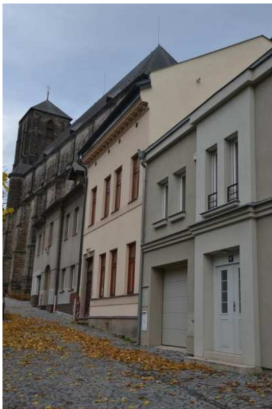
Celkový pohled na jižní frontu domů na Mariánském náměstí, dům č. p. 15 (druhý zprava), foto IP 2013.
